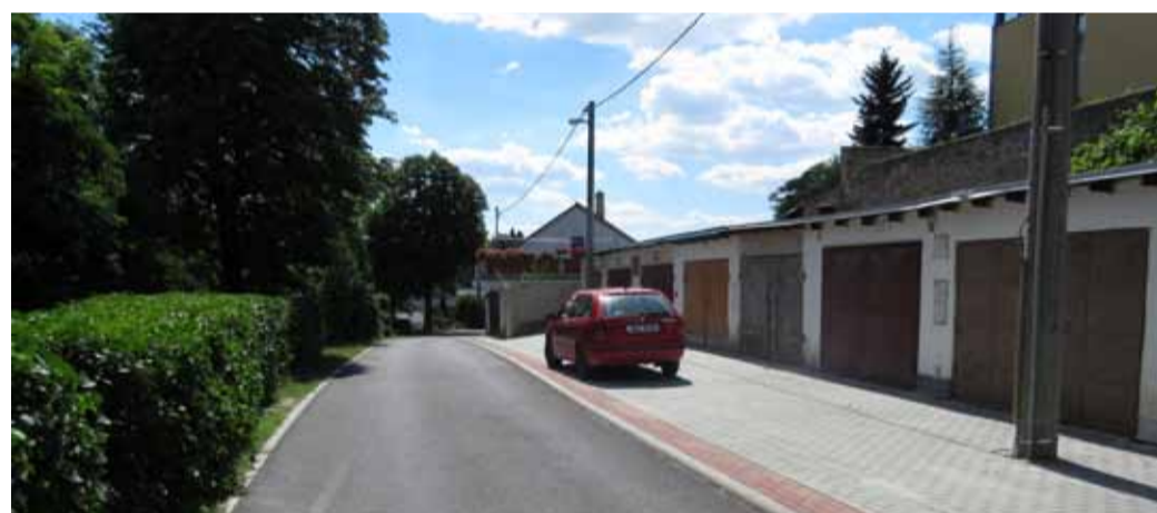
Komunikace Pod hradbami.
