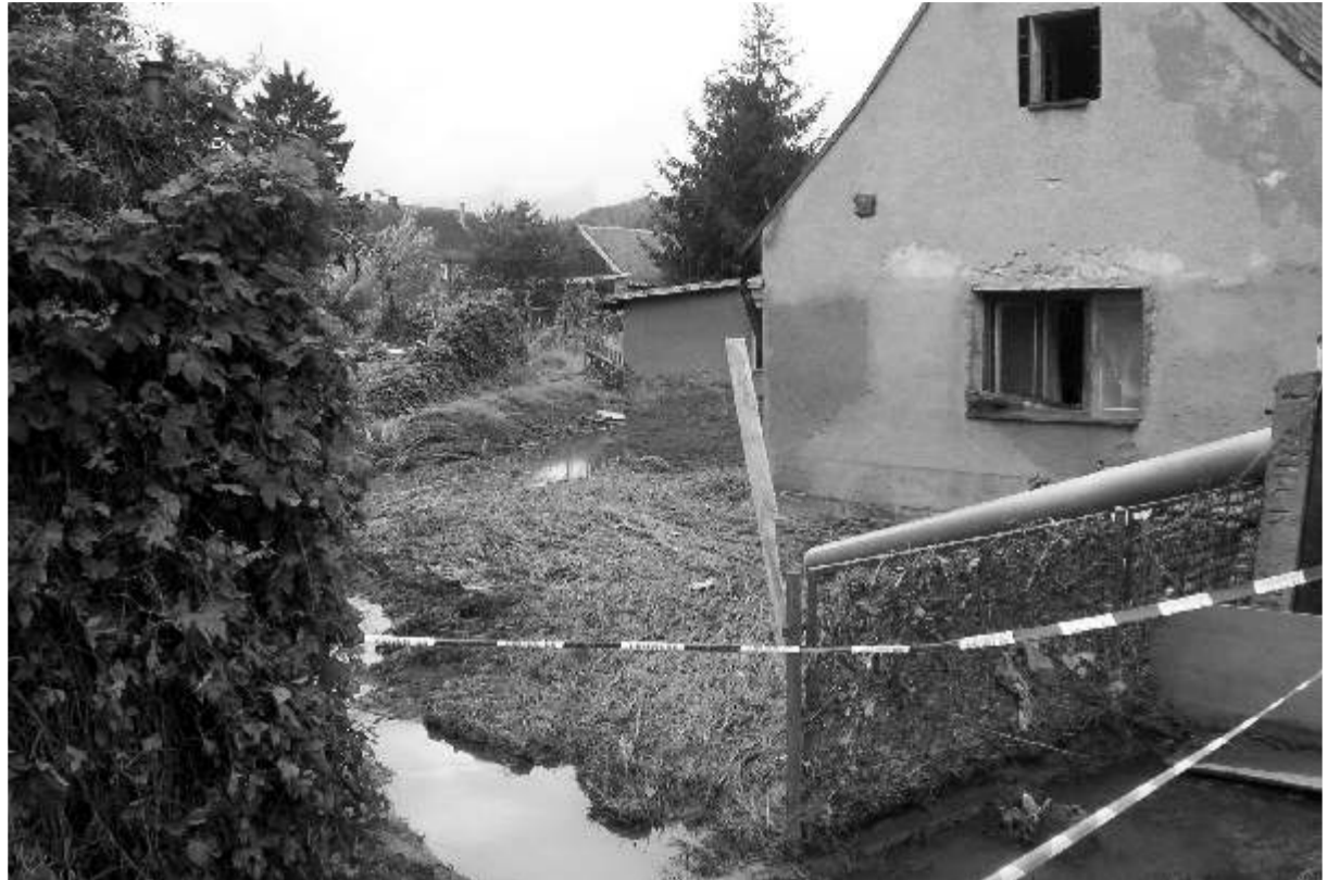
Povodní postižený dům v Bílém Kostele nad Nisou, určený k demolicí.
