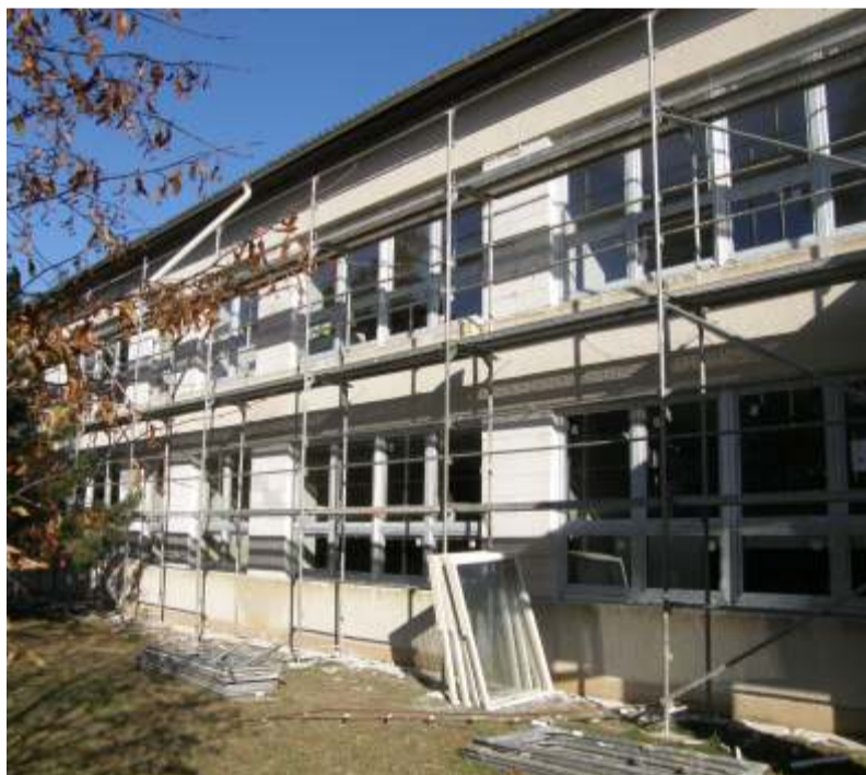
Stavební úpravy pavilonu B.
