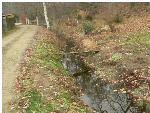
Obr.44 - Zanesené a upravené nekapacitní odpadní koryto v chatové zástavbě
