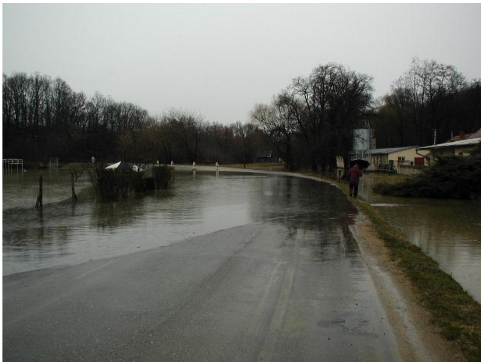
Obr.35 - Voda z rybníka nestíhá odtékat korytem a propustky, hladina v Rokytné je níže
