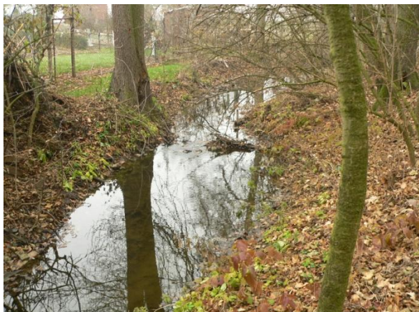
Obr.43 - Zanesené odpadní koryto
