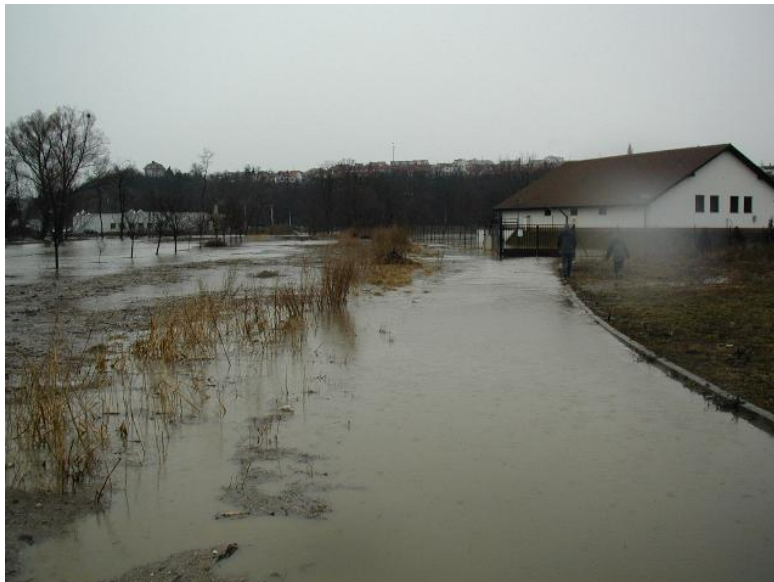
Obr.38 - Povodeň 2006 u areálu ČOV
