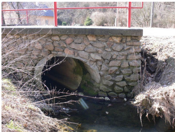
Obr.41 - Málo kapacitní propustek pod silnicí
