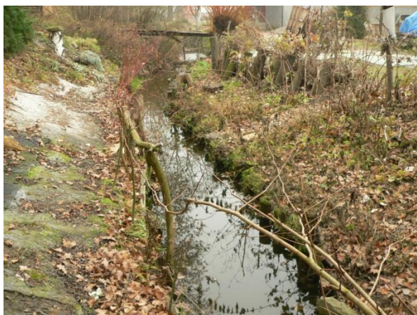
Obr.45 - Zanesené a upravené nekapacitní odpadní koryto v chatové zástavbě
