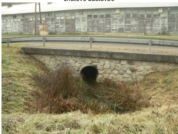
Obr.47 - Propustek pod silnicí na korytě od spodní výpusti z rybníka
